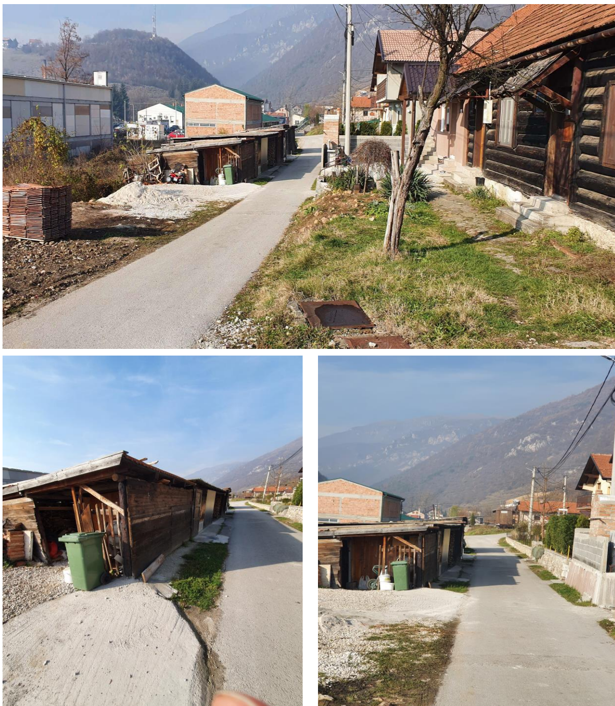
Slika 17 – 7 pomoćnih objekata u naselju Dolac na Lašvi
